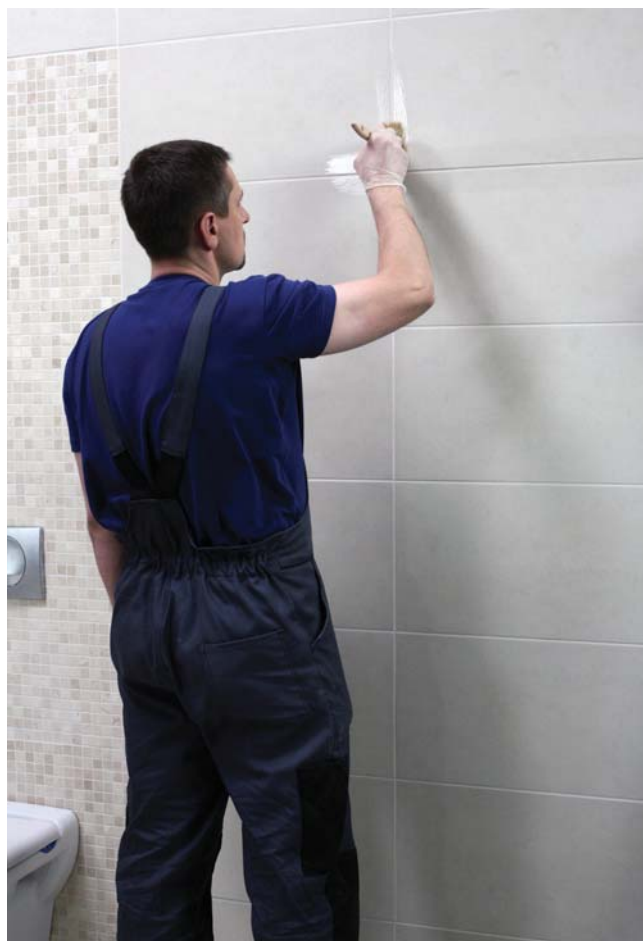
Fugę można dodatkowo zabezpieczyć silikonowym impregnatem Ceresit CT 10
