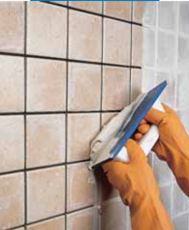
Spoinowanie płytek typu monocottura
