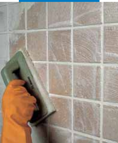
Czyszczenie płytek typu monocottura przy użyciu Scotch-Brite
