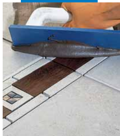
Spoinowanie przy użyciu pacy podłogi ceramicznej z elementami drewnianymi
