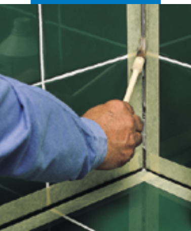
Gruntowanie boków szczeliny przy użyciu Primer FD
