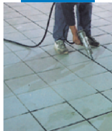
Wykonanie spoin Mapesil AC na posadzkach za pomocą pistoletu pneumatycznego
