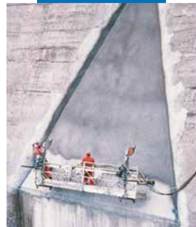
Nanoszenie Mapelastic metodą natryskową na zaporze wodnej
