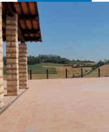
Prywatny taras w Cereseto (Włochy) zabezpieczony hydroizolacją Mapelastic
