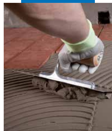
Montaż płytek na zaprawie klejącej Granirapid na wykonanej uprzednio hydroizolacji Mapelastic
