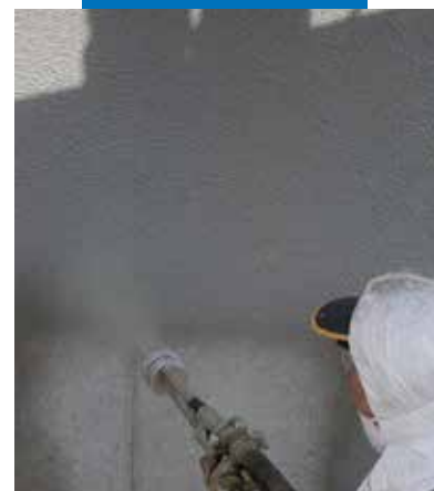
Nanoszenie Mapelastic metodą natryskową
