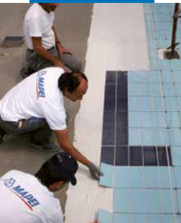
Montaż płytek ceramicznych na warstwie hydroizolacji Mapelastic
