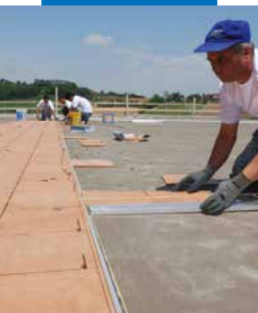
Montaż płytek ceramicznych z zastosowaniem Kerabond T + Isolastic
